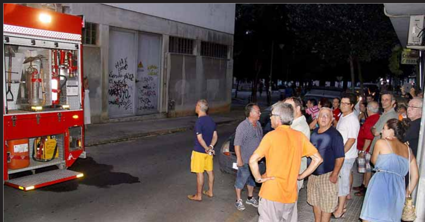
Vecinos de Santa Catalina observan los trabajos de los bomberos en la subestación eléctrica. FOTO: JULIÁN AGUIRRE
