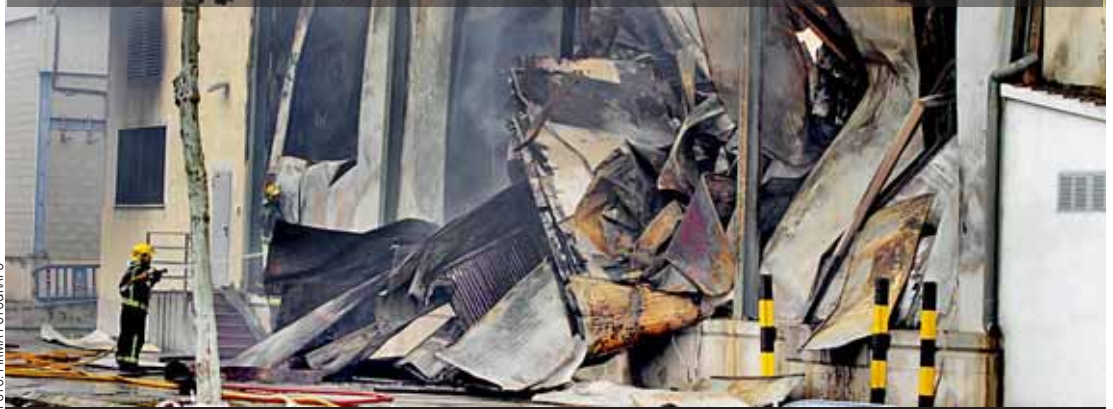
Un bombero lanza agua en la nave de 12.000 metros cuadrados destrozada en Mercapalma.
