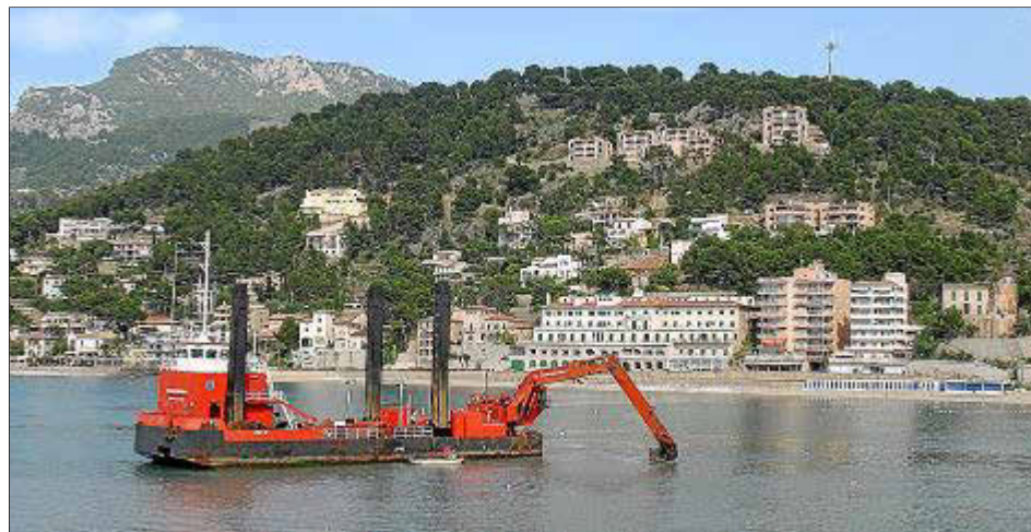
Tras años de obras, el agua de sa Costera llegó al Port de Sóller en 2008. Foto: Archivo UH
