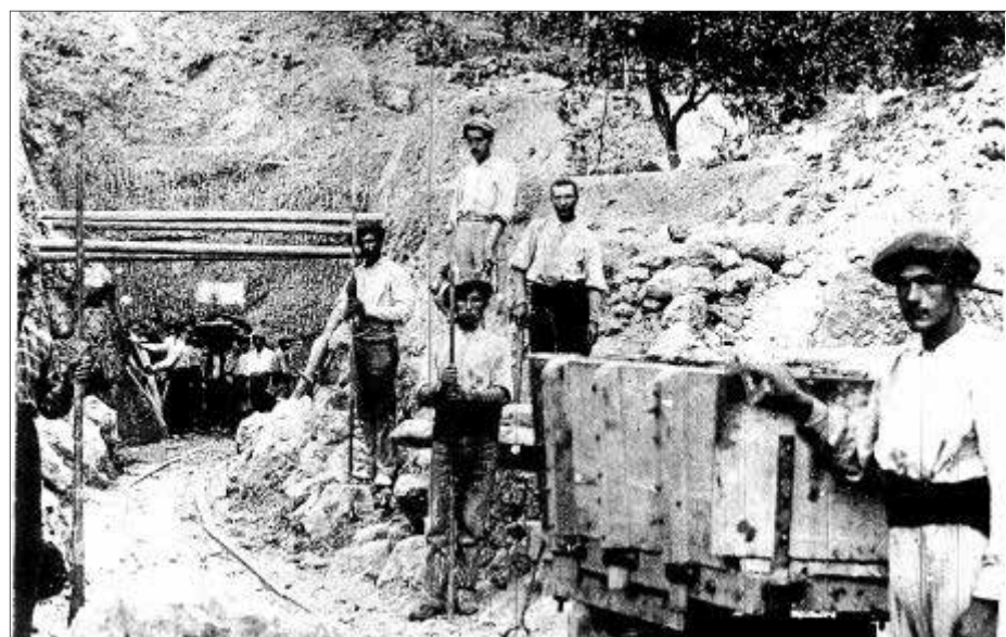
Imagen de las obras de perforación del túnel mayor. Foto: Ferrocarril de Sóller
