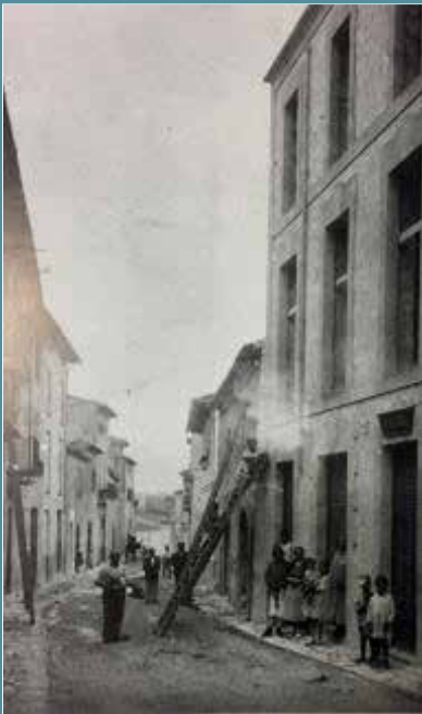
Instalación de la red eléctrica en la calle Mayor, años 20.
