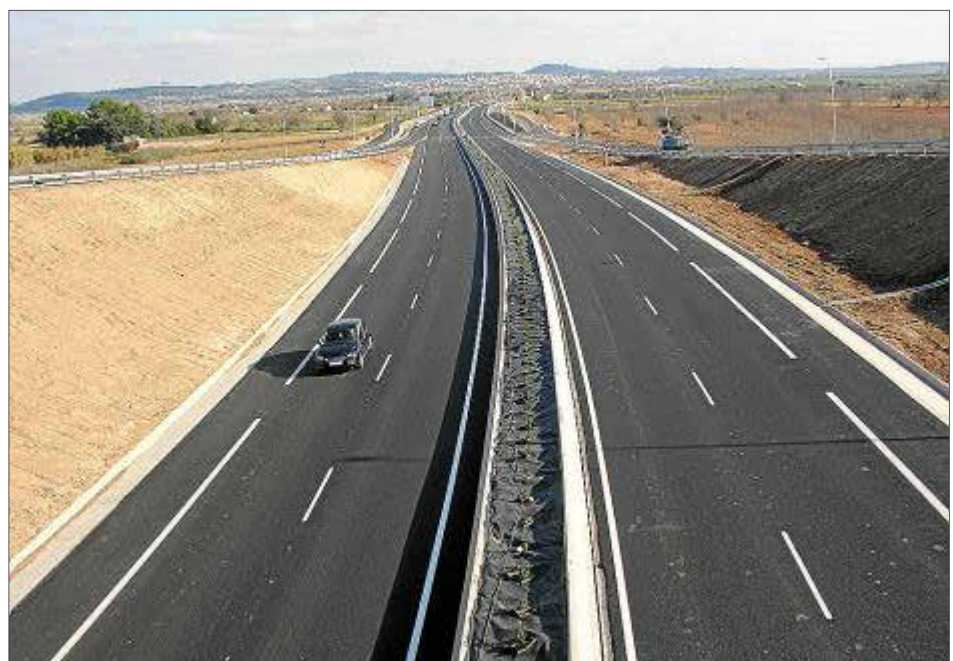
Las obras del desdoblamiento se iniciaron en 2004 y finalizaron en 2006. Foto: Archivo UH
